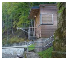
Nivel de agua con sensor de radar
