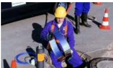
Instalación de caudalímetro
