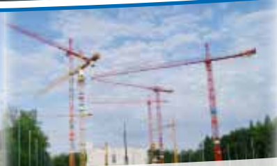
Monitorización en Zonas de Construcción
