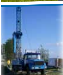
Ensayos de Bombeo
